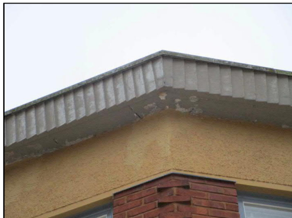
Kuva 25. Rakennuksen räystäsrakenteet ovat betonirakenteisia. (Julkisivun kuntotutkimus 17.10.2016, Raksystems Insinööritoimisto)
